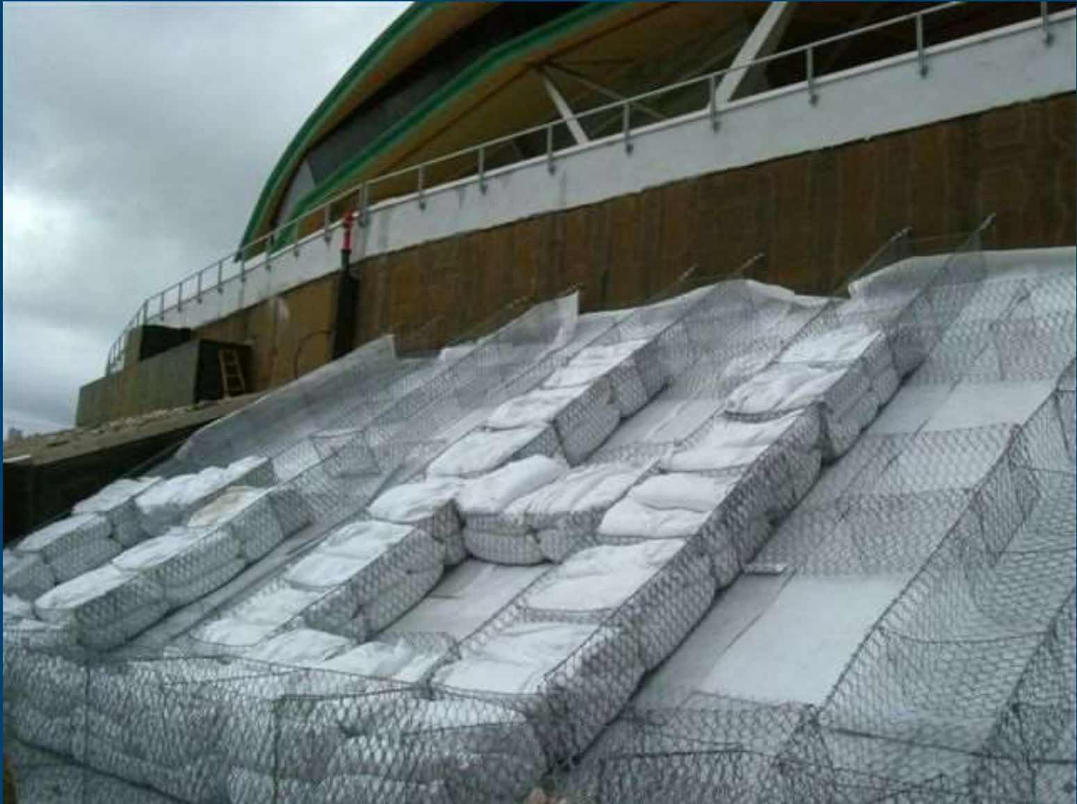
Aula liturgica Padre Pio – San Giovanni Rotondo – progetto verde: Arch. Enzo Paoli
