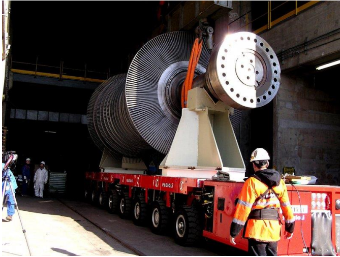
Smantellamento turbina e realizzazione Stazione Gestione Materiali - Caorso
