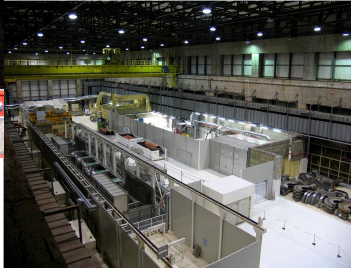
Smantellamento turbina e realizzazione Stazione Gestione Materiali - Caorso
