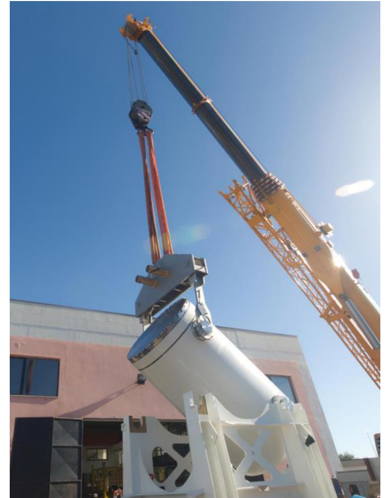
Realizzazione cask dual purpose per combustibile irraggiato Elk River - Trisaia
