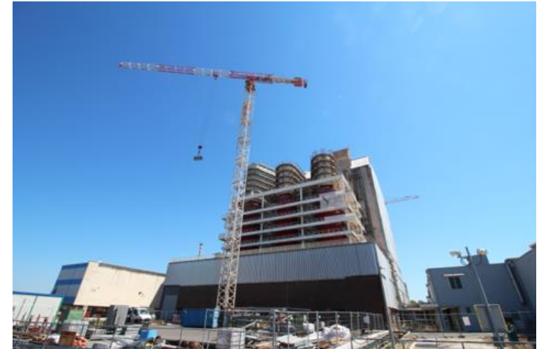
Smantellamento boiler Latina
