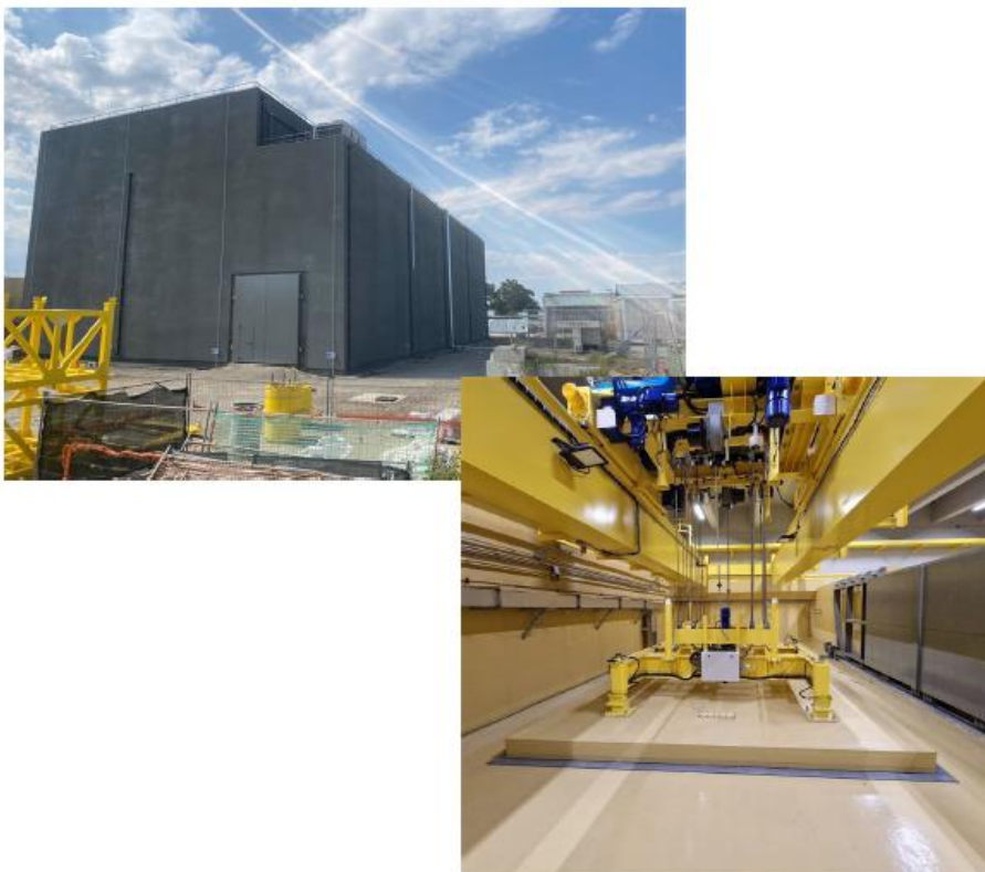
Nuovo deposito temporaneo per manufatti cementati di media attività (ILW) e cask - Trisaia
