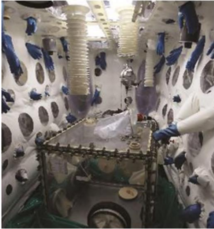
Smantellamento scatole a guanti alfa contaminate – IPU Casaccia
