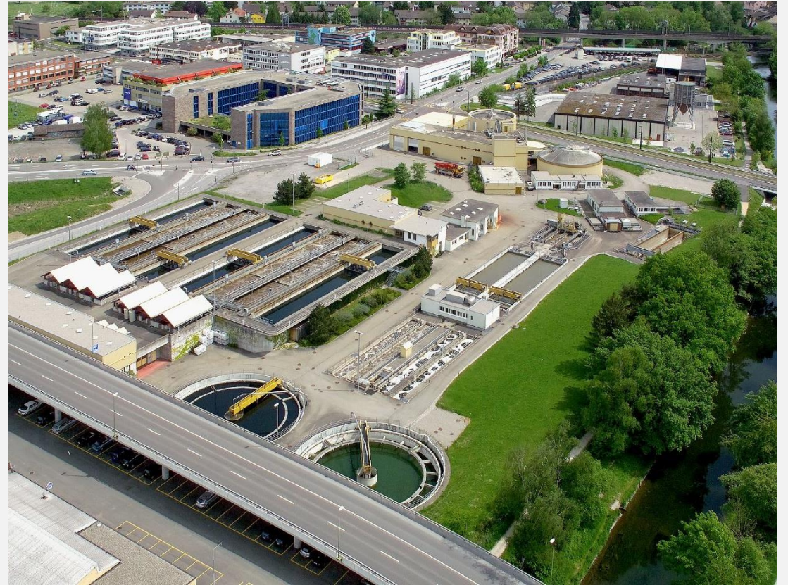
Vista aerea dell'impianto di Kloten-Opfikon
