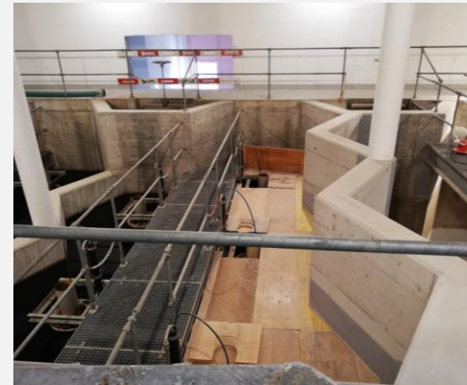
Innalzamento delle pareti dei filtri
